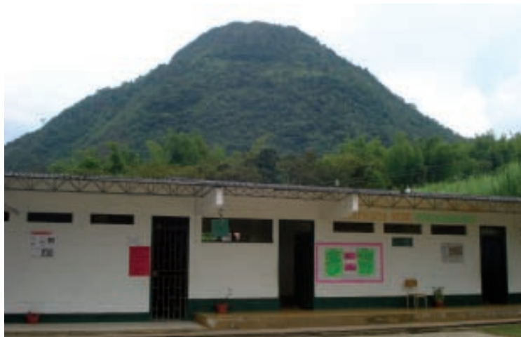
Escuela local, Comunidad de Dosquebradas
